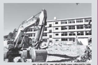
3校目の新築工事現場
