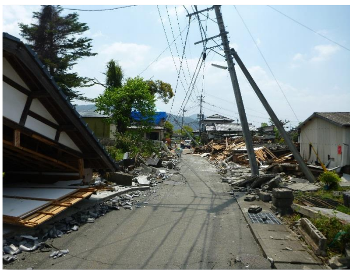
図 1-1 熊本地震における建物被害
