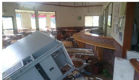
熊本地震における家具転倒被害
