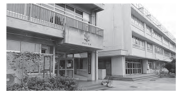
築49年を経過した校舎もある男衾中学校
