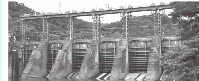
**玉**淀ダムは、昭和39年に建設された重力式のコンクリートダムです。荒川水系では最も下流にあり、6門の水門をもっているのが特徴的です。ダムに溜められた水は、農業用水と発電用水に使用されています。
