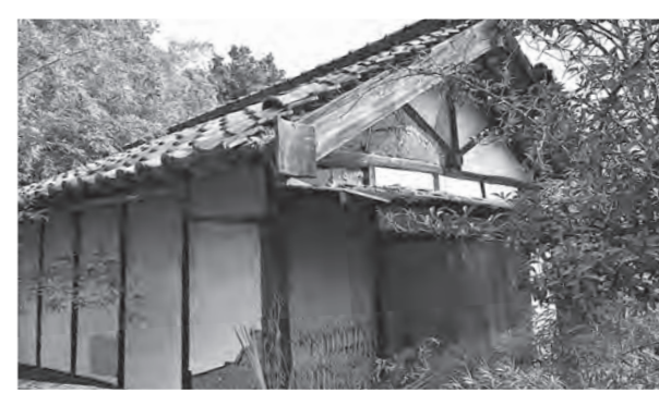
老朽化により危険な空き家もあります
