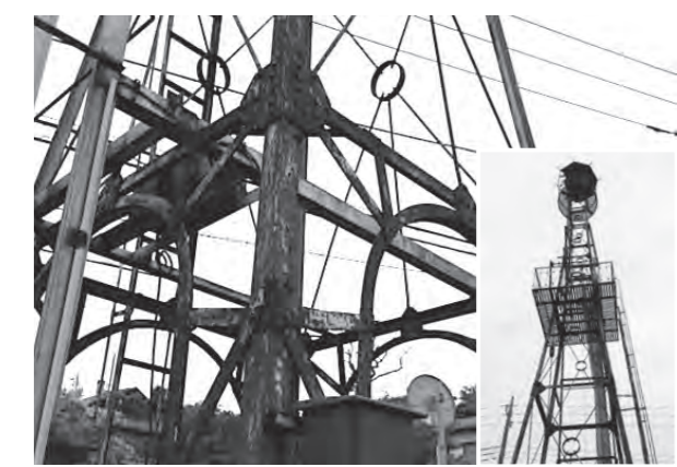
老朽化の進む火の見櫓
