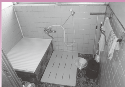
浴室改修工事前
