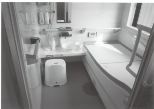
浴室改修工事後
