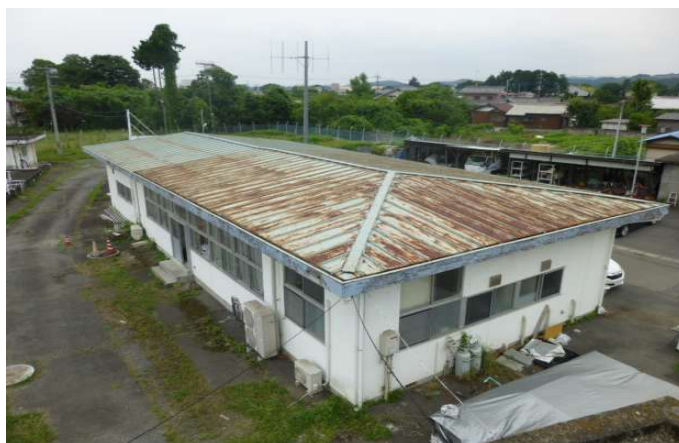
象ヶ鼻浄水場管理棟
