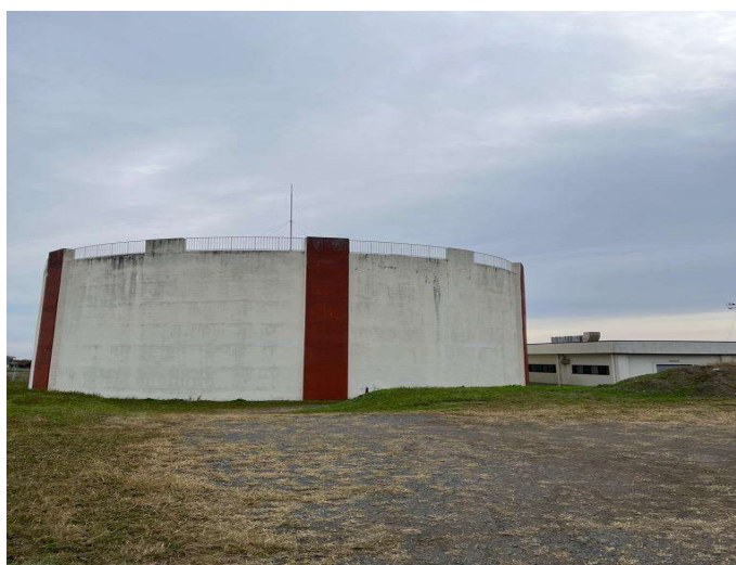
寄居配水場配水池
