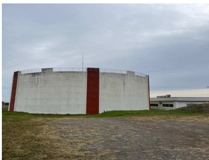
寄居配水場配水池
