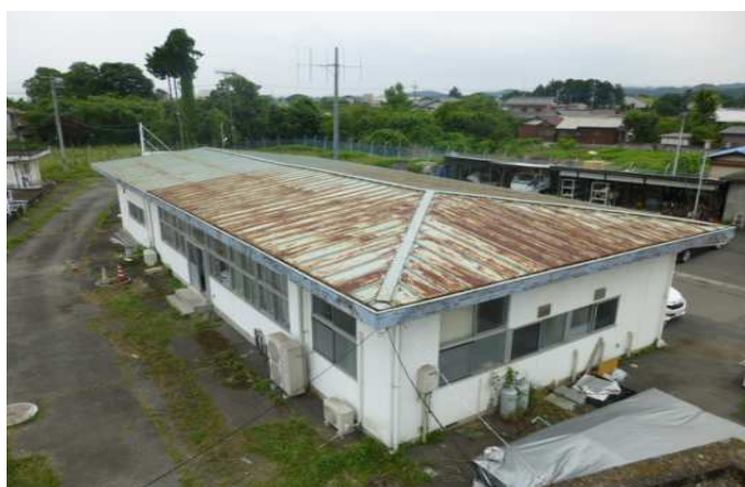
象ヶ鼻浄水場管理棟
