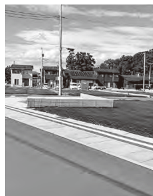
工事終了、分譲住宅建築進む
