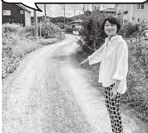
「長年、穴埋めやグレーダーで修繕していただいているんですが、夜は真っ暗で足元が悪く危険度も増します」(男衾・種橋和枝さん) たねはしかずえ
