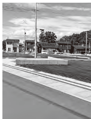
工事終了、分譲住宅建築進む
