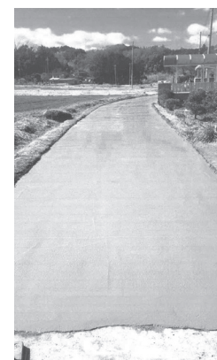
舗装工事後の道路
