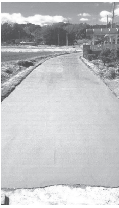
舗装工事後の道路
