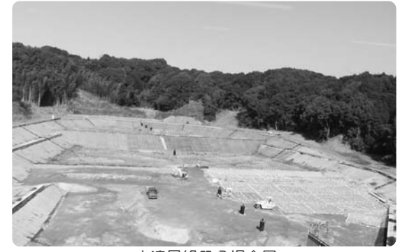
中遠最終処分場全景
