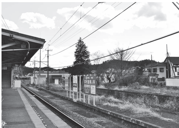
整備が予定されている男衾駅西口側
