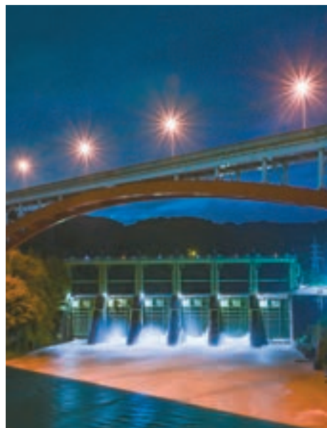
玉淀ダムと有料道路 大迫力のダム放流と天空へ伸びるかのような有料道路が絵になるスポット。「銀河鉄道の夜」を連想させるファンタジーな一枚。
