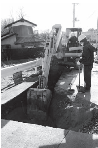
古い水道管を新しくしています
