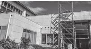
維持管理のための調査が進行中
