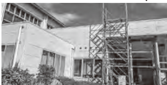
維持管理のための調査が進行中
