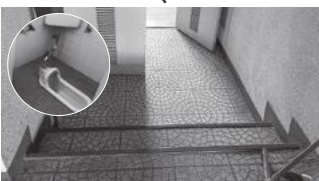
トイレ入口の段差もバリアフリーに
