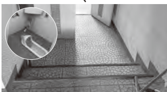
トイレ入口の段差もバリアフリーに
