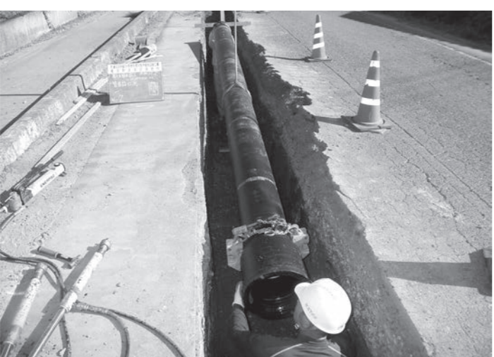
古くなった水道管を新しくする「老朽管布設替工事」 今年度は、桜沢・寄居・男衾・用土・折原地区など6カ所で、総延長2265mの更新に向けて、計画どおりに工事が進んでいます。
