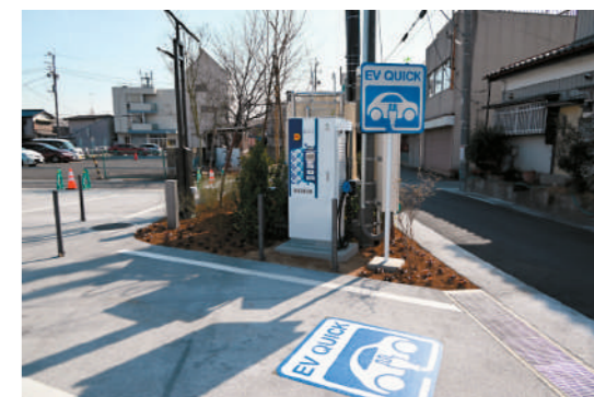
急速充電器利用専用の駐車場
