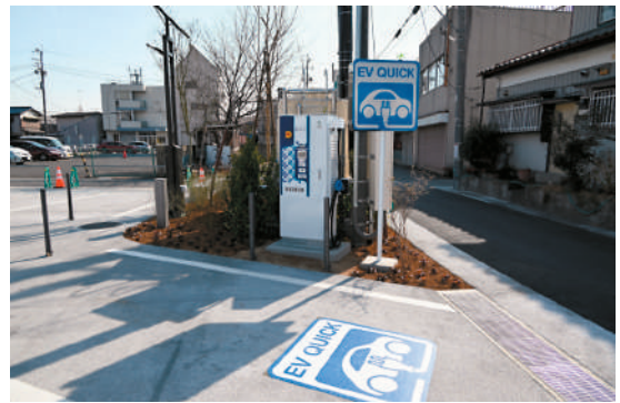
急速充電器利用専用の駐車場
