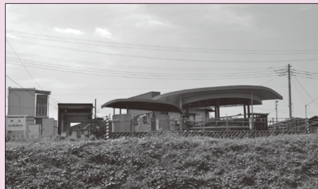
のどかな風景に溶け込んだコミュニティステーション
