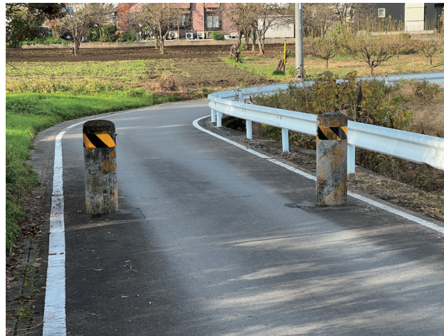
（町道にあるコンクリート柱）
