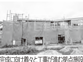
完成に向けて着々と工事が進む拠点施設
