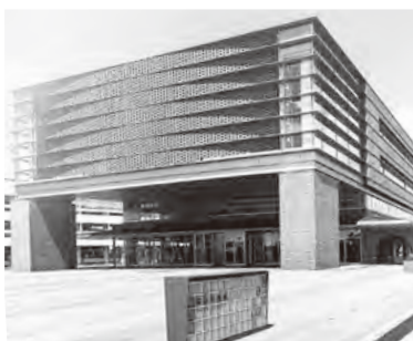
深谷市の新庁舎（屋上にソーラーパネルを敷き詰めています）
