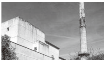
解体が急がれる崩壊寸前の煙突
