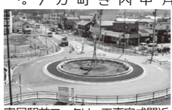
寄居駅前ロータリー工事完成間近
