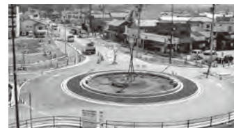
寄居駅前ロータリー工事完成間近
