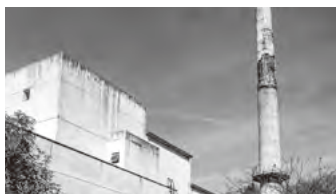
解体が急がれる崩壊寸前の煙突
