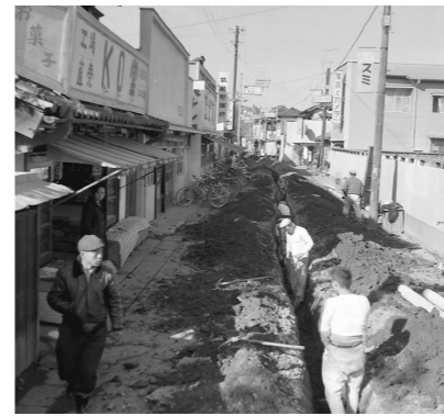
草創期の配水管布設工事(昭和35年ごろ)
