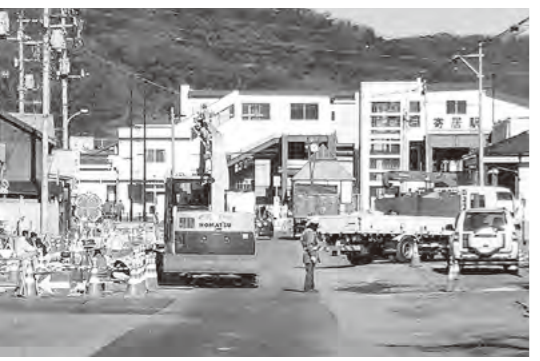
駅前道路、電線埋設工事 着々と
