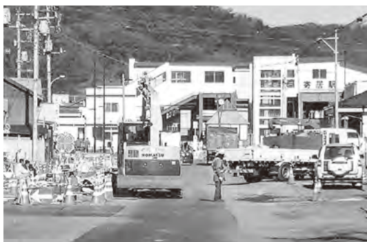
駅前道路、電線埋設工事 着々と
