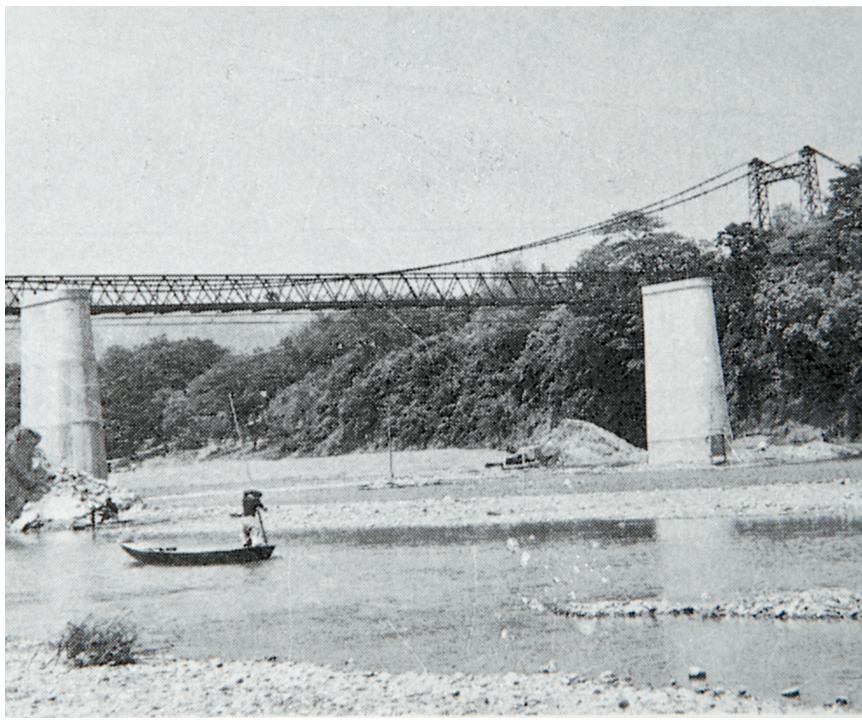
建設中の新正喜橋と奥に写る旧正喜橋
