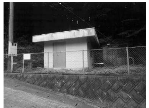
増圧施設(中継施設)
