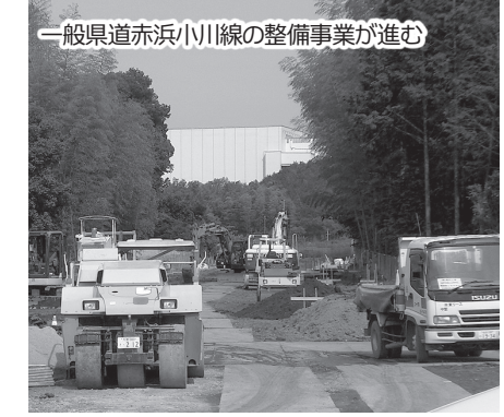
一般県道赤浜小川線の整備事業が進む
