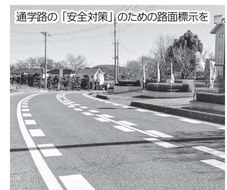
通学路の「安全対策」のための路面標示を
