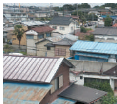
空き家・空き店舗の情報収集を行い、今後どのように有効活用するか計画を立てています。
