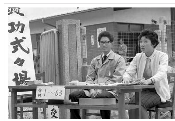
象ヶ鼻浄水場竣工式の受付
