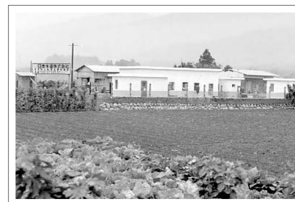
完成当時の象ヶ鼻浄水場
