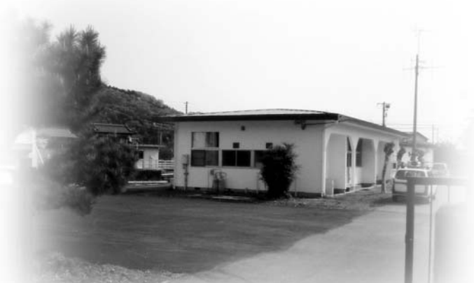
現在の象ヶ鼻浄水場
