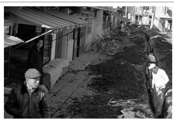
水道管の布設工事
