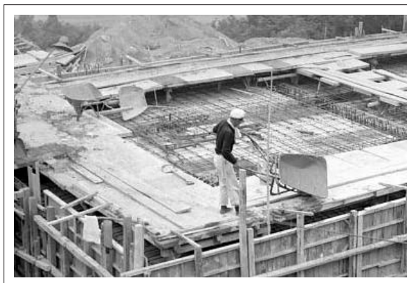
常木配水池の建設工事
