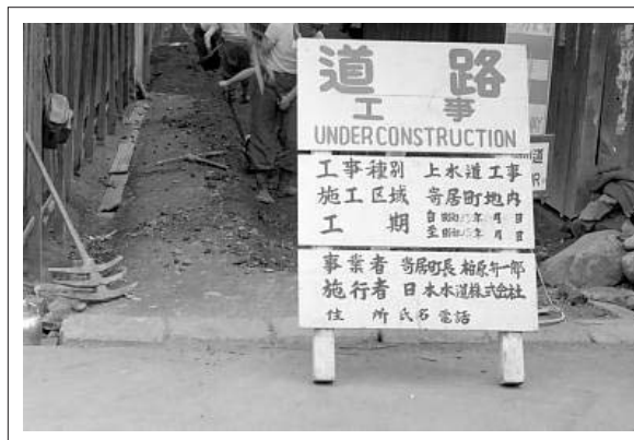
水道管の布設工事
