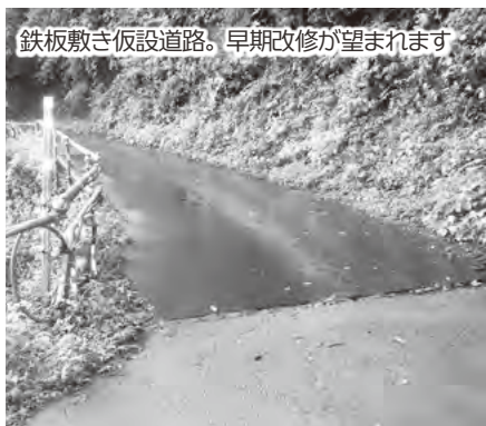
鉄板敷き仮設道路。早期改修が望まれます
