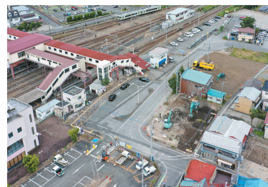
寄居駅南口駅前広場整備工事 (令和2年～4年度)
