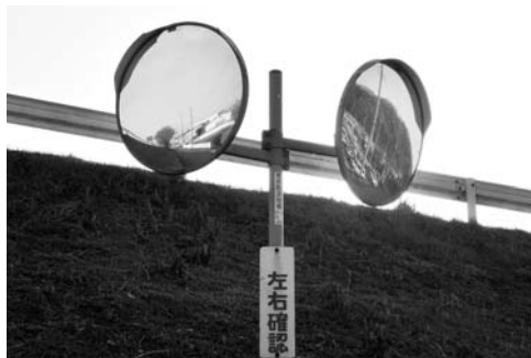
危険箇所改善のために設置されるカーブミラー
