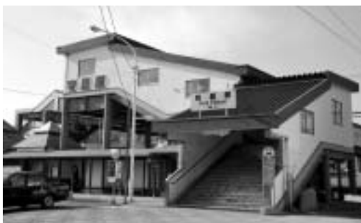
エレベーターが設置される寄居駅
