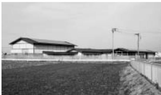
建物が完成した新男衾コミュニティセンター
