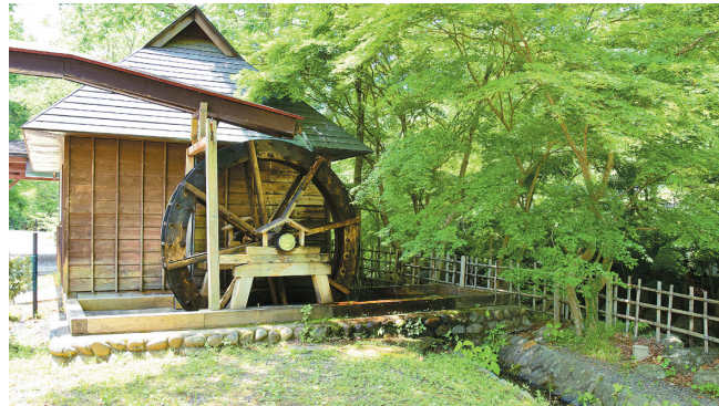
▲釜伏山からの日本水で回る水車
