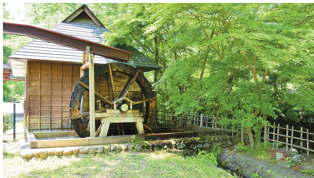
▲釜伏山からの日本水で回る水車
