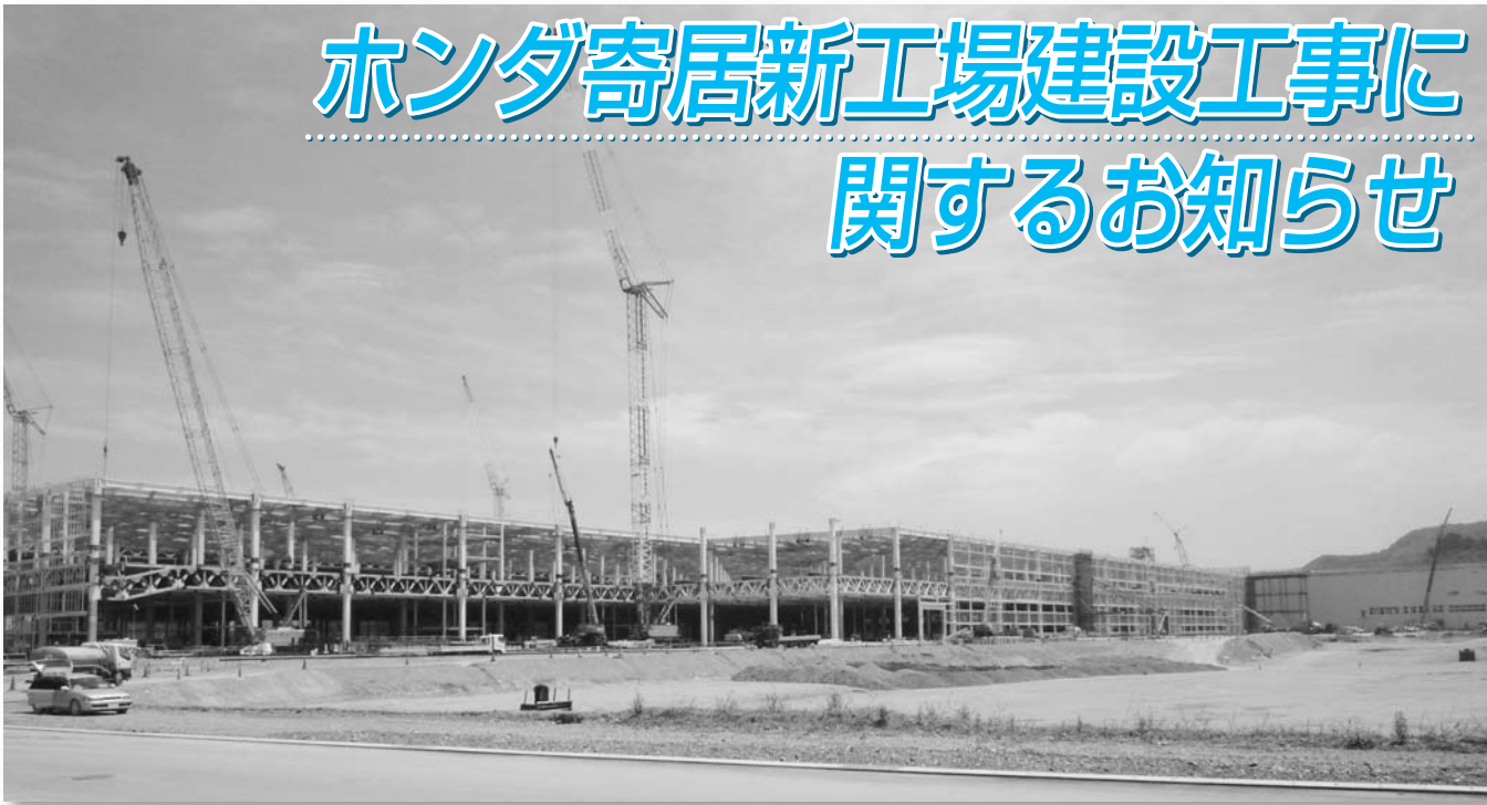
ホンダ寄居新工場建設工事状況（平成21年7月撮影）
