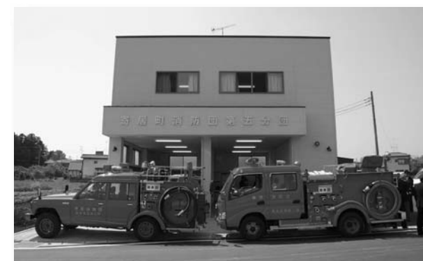
完成した詰所と消防ポンプ自動車
