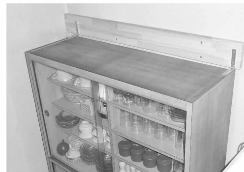
L型金具を設置して固定した家具
