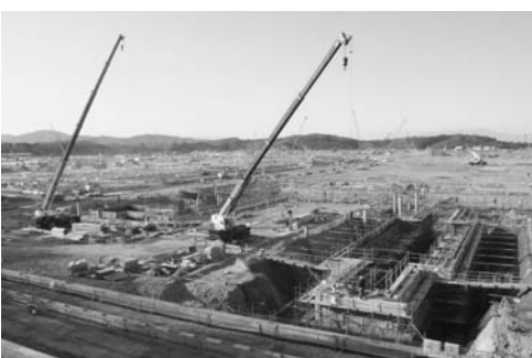
建物の建築工事が進んでいるホンダ寄居新工場建設現場
