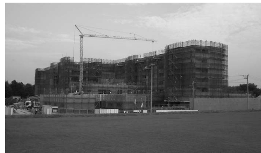
ホンダの寮建設工事状況 （西側のホンダグラウンドから撮影）
