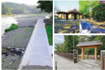
川の国埼玉はつつプロジェクトにより、荒川沿いの玉淀河原や雀宮公園周辺の整備が完了しました。住民の散歩コースとして、また、中心市街地への来訪者が立ち寄るスポットとして賑わいを生み出しています。
