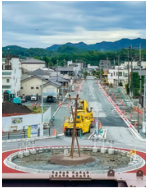
寄居駅南口の景色が大きく変わりました。中央通り線の整備により、一方通行の道路が対面通行可能な幅約16mの道路に生まれ変わり、寄居駅南口へのアクセスとともに、回遊性が向上しました。
